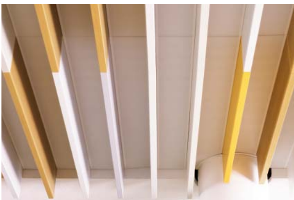
Volksbank Raiffeisenbank, Dachau
